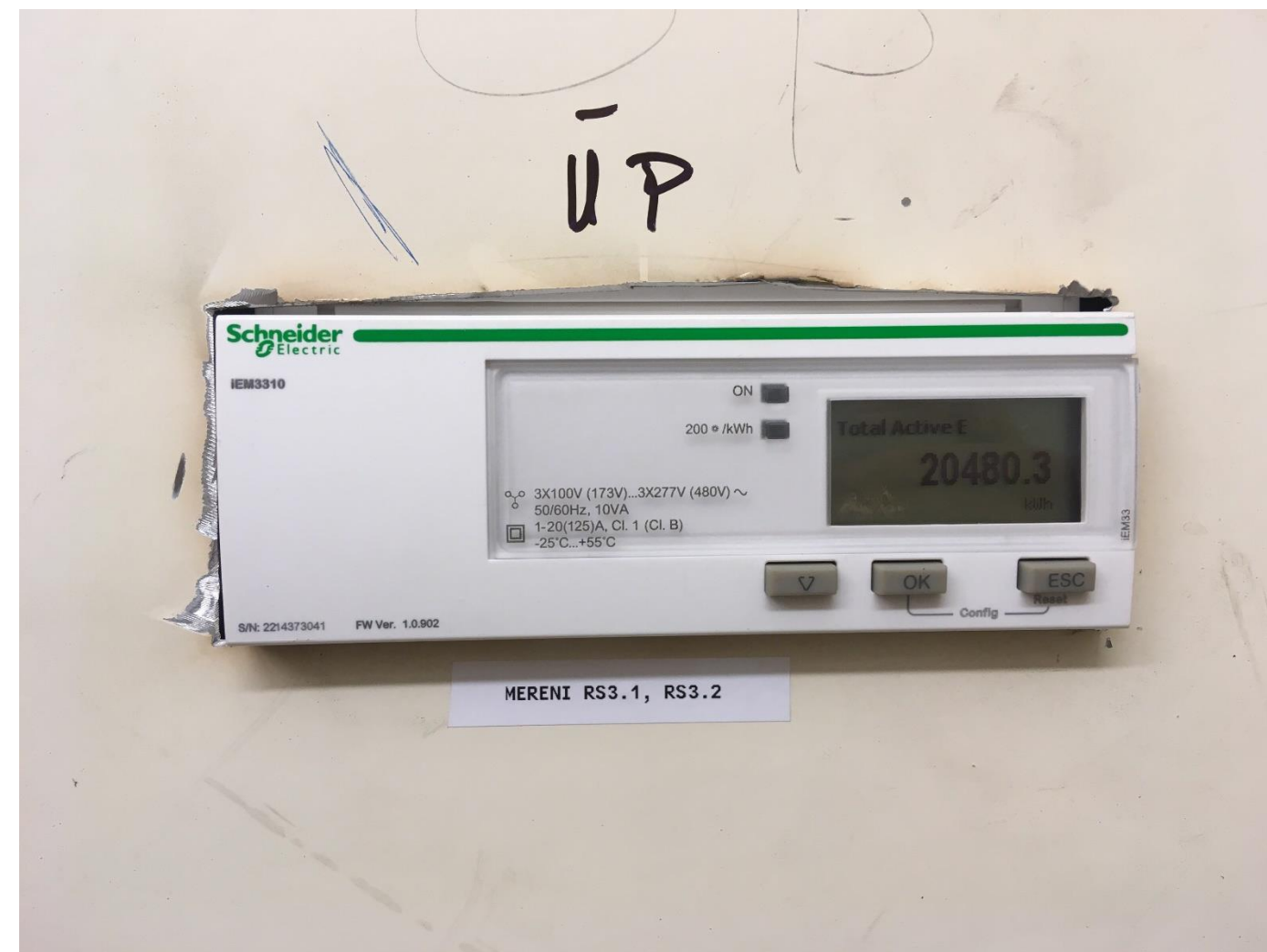
Ukázka provedení otvoru pro doplňovaný elektroměr místa – ostré hrany, ze zadní strany nezačištěné, nebezpečné a neestetické provedení.
